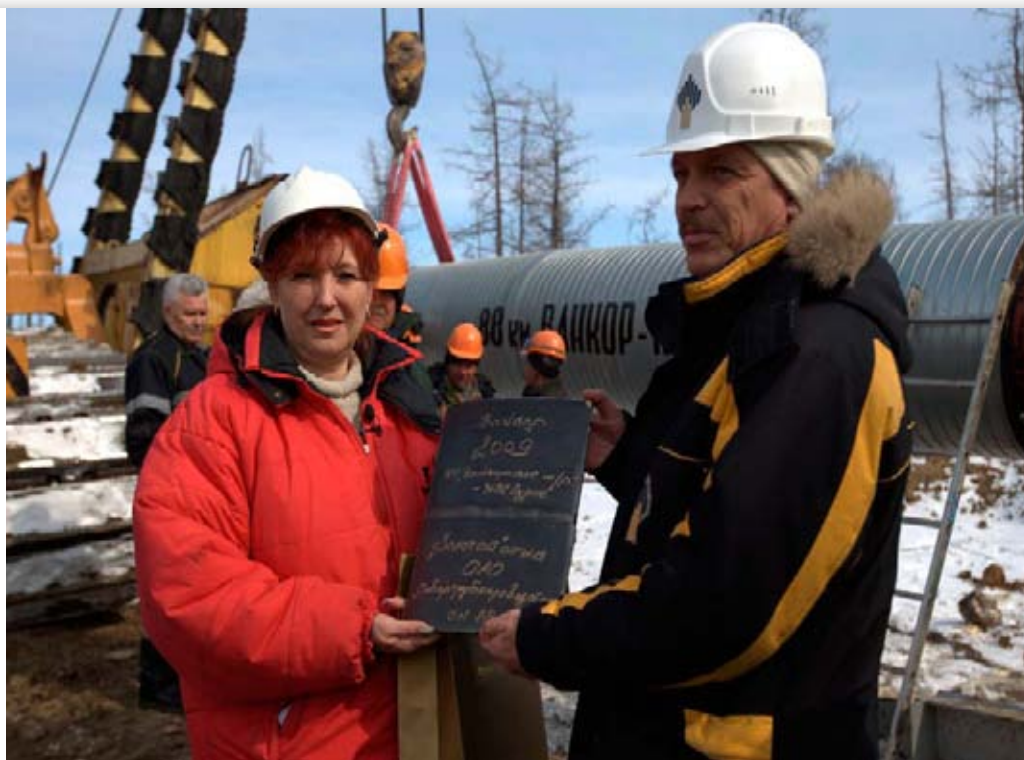
Сварен символический «последний шов» нефтепровода Ванкор - Пурпе
