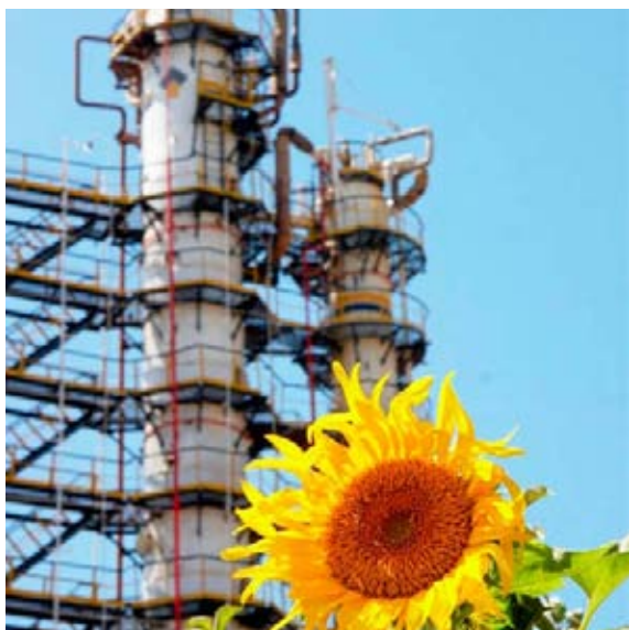
Установка ГФУ-3 Куйбышевского НПЗ
