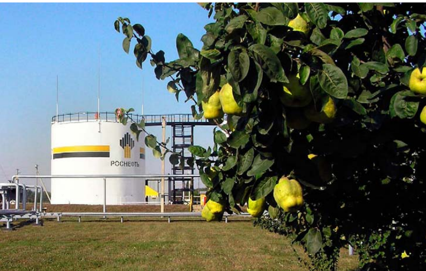
На Славянском месторождении Краснодарнефтегаза
